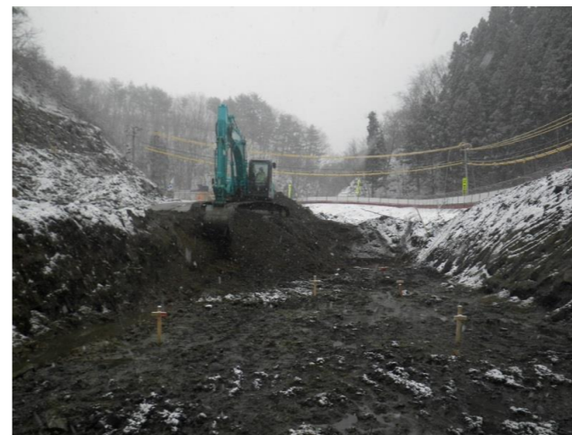
ボックスガート設置部の掘削
