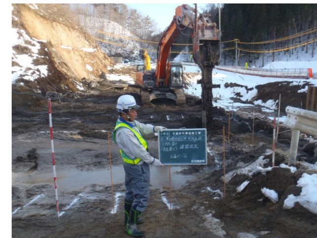
地盤改良工（パワーブレンダー工法）
